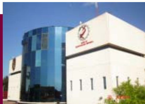
Instalaciones del CBG
