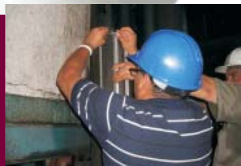
Trabajos de Medición
