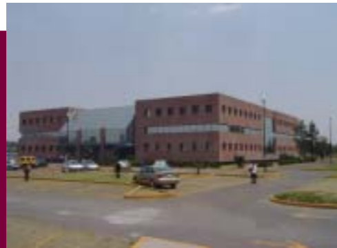
Instalaciones del CIC
