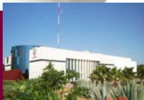
Instalaciones del CBG
