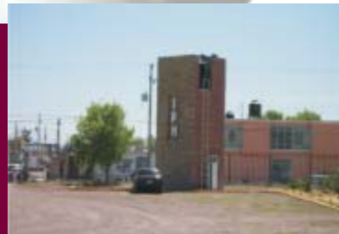
Tanque de Agua Elevado
