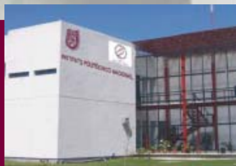
Instalaciones del CBG
