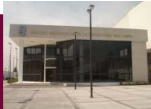
Instalaciones del CMP+L
