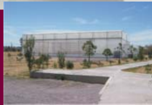
Invernadero en Instalaciones del Centro
