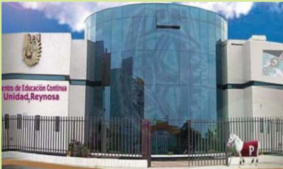
Instalaciones del CEC Unidad Reynosa
