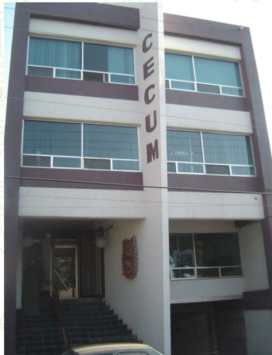
Instalaciones del CEC Unidad Morelia
