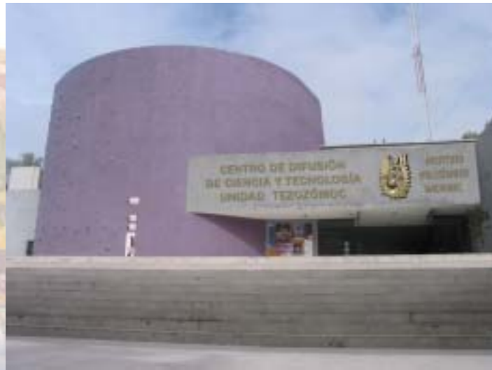
Instalaciones del Centro
