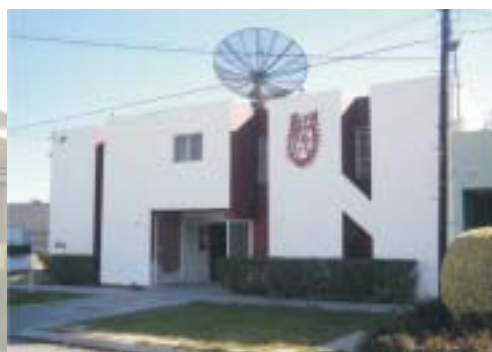
Instalaciones del CEC Los Mochis
