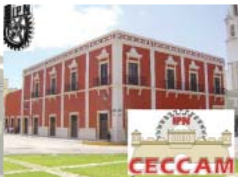
Instalaciones del CEC Campeche
