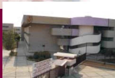
Instalaciones del Centro
