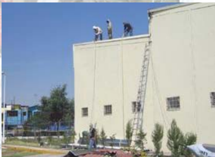
Reparaciones en el CECyT "Cuauhtémoc"
