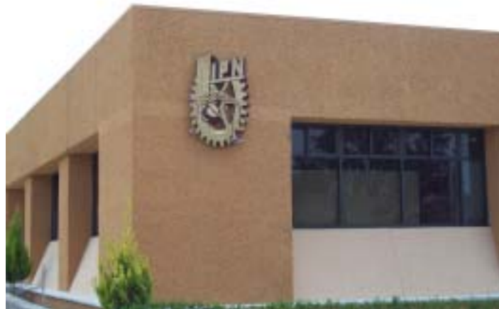
Instalaciones del CIBA
