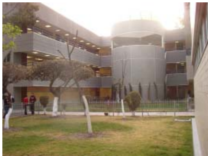
Instalaciones del CET
